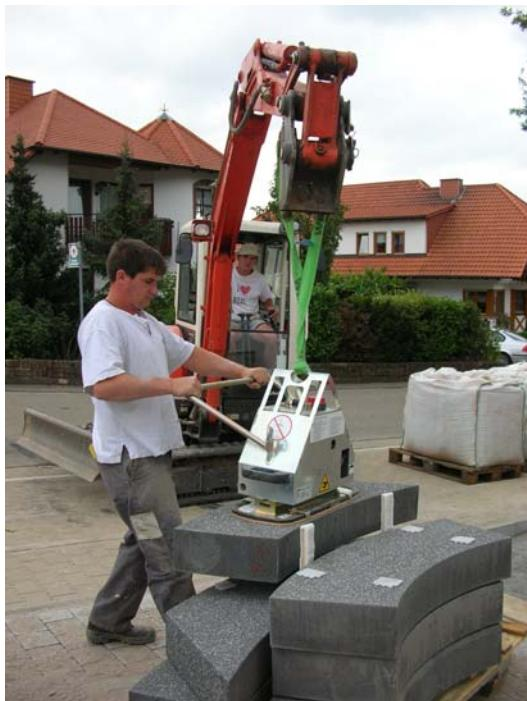
Batteriebetriebenes Vakuum-Lasthaftgerät zum universellen Verlegen von saugdichten Steinplatten o.ä. bis zu einem Gewicht von 400 kg. Hier beim Verlegen von radienförmigen „Flair-Blockstufen“ für eine Rundtreppe. Gewicht pro Stück bis ca. 200 kg.
